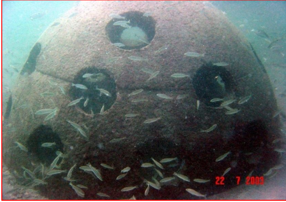
الشكل (3-6): برنامج تشييد الشعاب الصناعية بواسطة القباب الاسمنتية (المصدر: الإدارة العامة لحماية الثروة البحرية)
