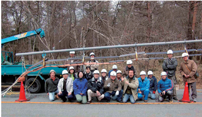
アニマルパスウェイ設置作業参加者の皆さん People constructing animal pathway.
